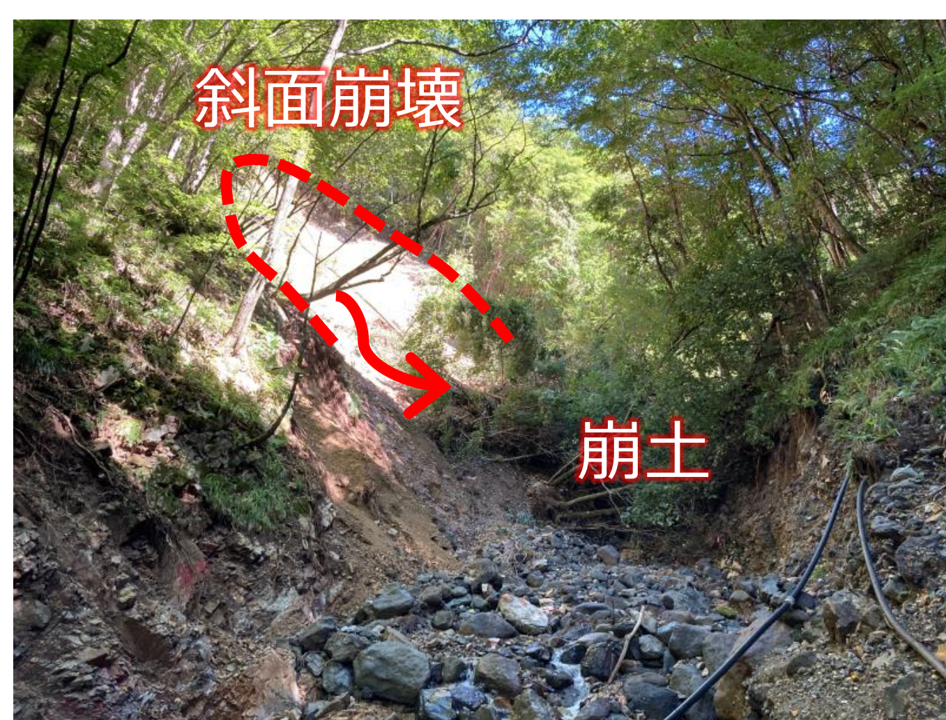
山地斜面の崩壊と崩土の溪流への流入
