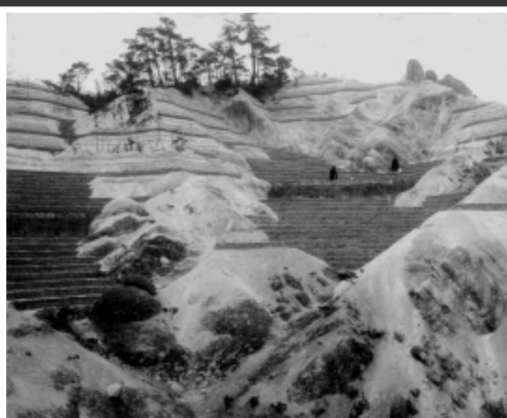
桐生試験地付近の国有林(現在一丈野国有林)で1916年度に行われた、はげ山砂防工事の施工前後の写真(滋賀森林管理署提供)
